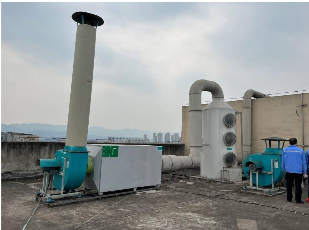
质检废气收集至“碱洗+活性炭吸附”装置处理后排放
